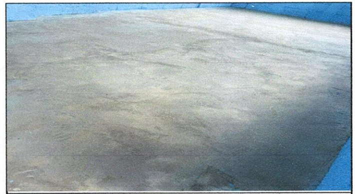
Foto 4: Sustitución de losa de patio
